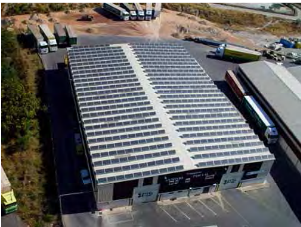
Foto 4. Instalación FV de 94,8 kWp en Alicante de Conergy-ENERSOL S.L.
