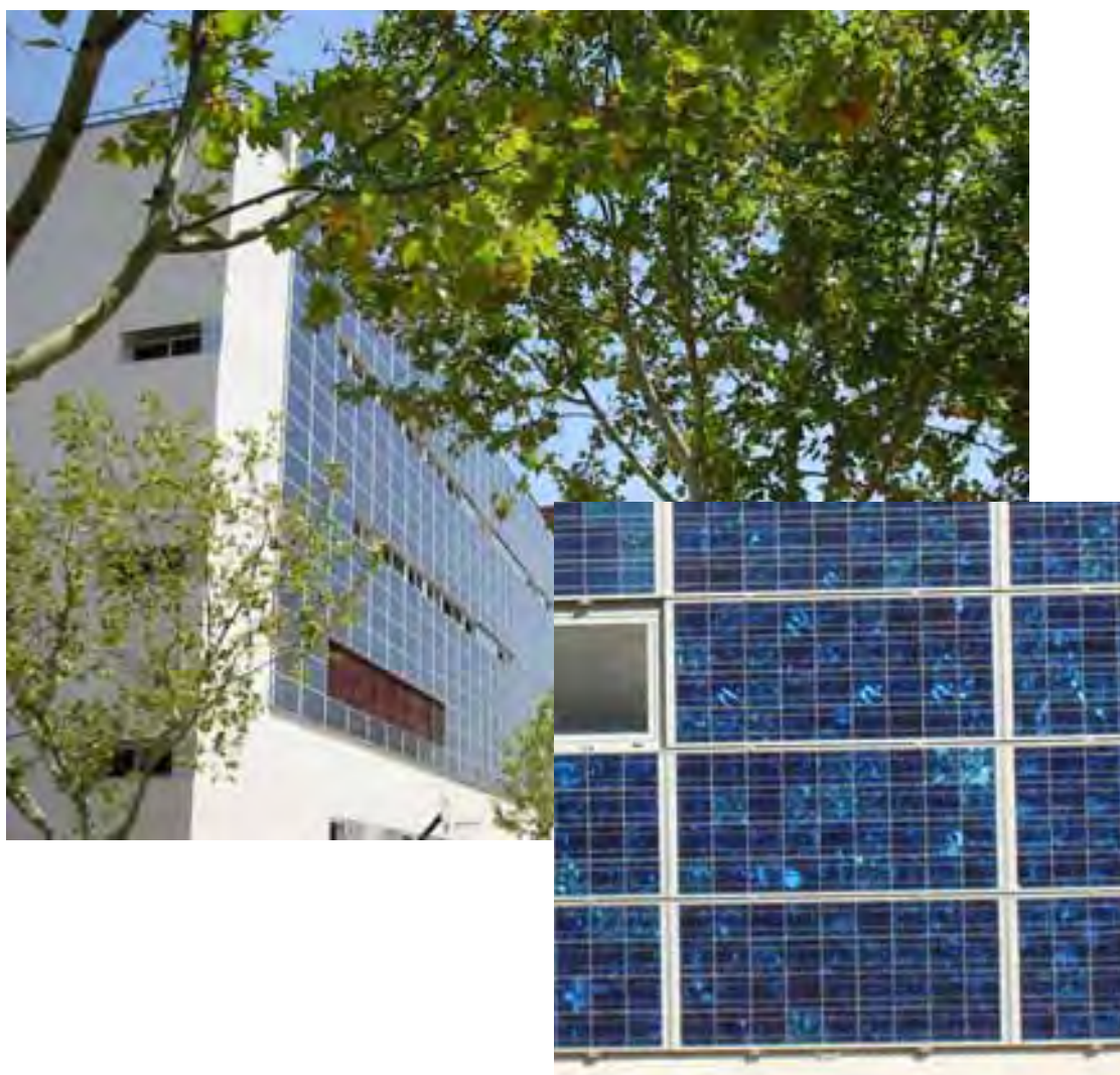
Foto 11. Instalación FV en la “Casa de la Juventud” de San Sebastián de los Reyes .
