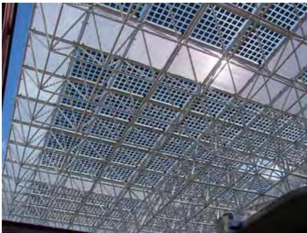
Foto 47. Cubierta espacial de Torre Garena.
