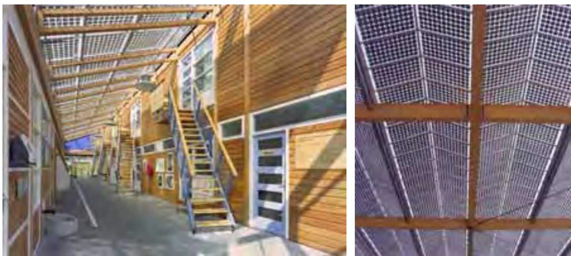
Foto 9. Cubierta acristalada con módulos fotovoltaicos.
