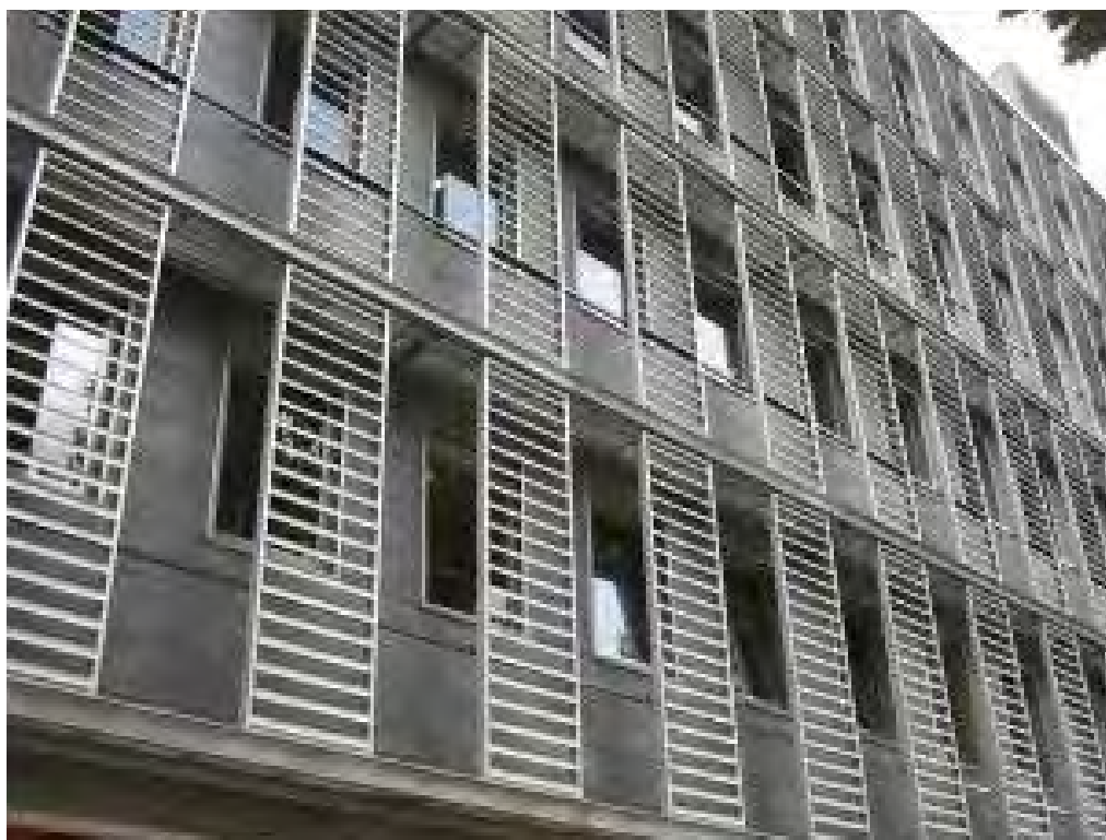
Foto 32. Fachada ventilada del edificio Trasluz.
