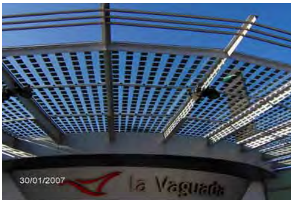
Foto 43. Campo Fotovoltaico nº 3.
