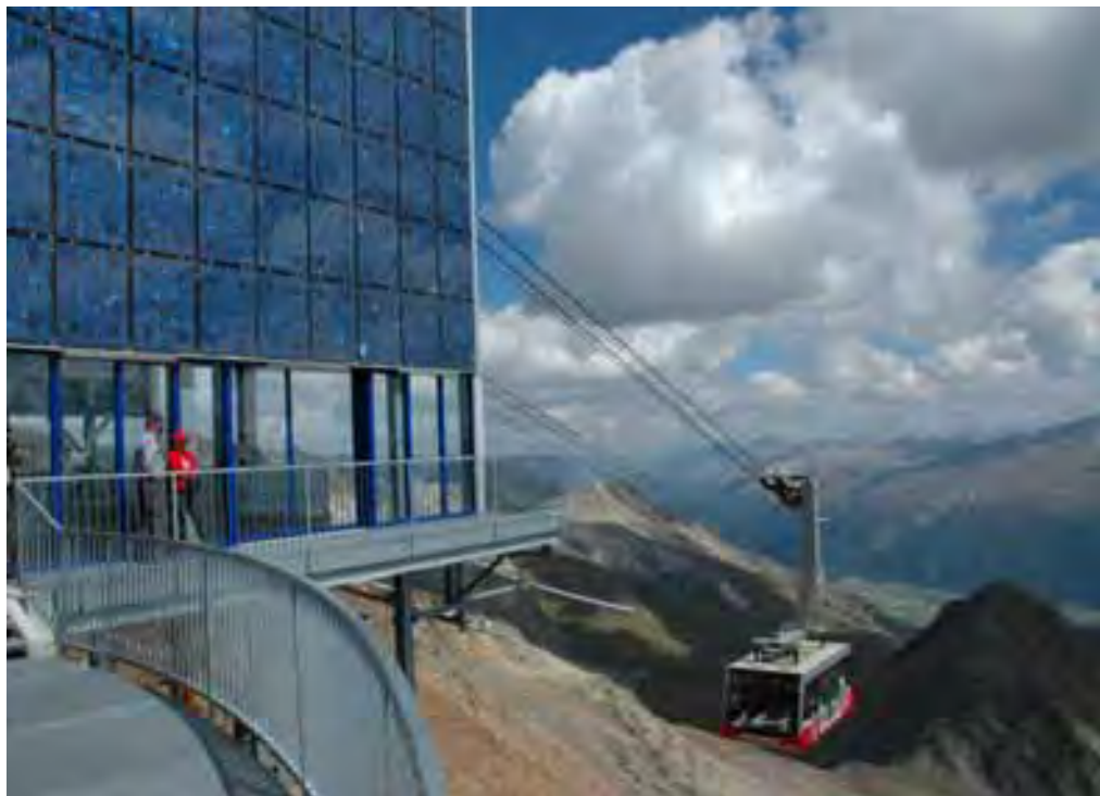
Foto 16. Fachada FV de la Estación Teleférico (St. Moritz – Suiza) realizado por Conergy.
