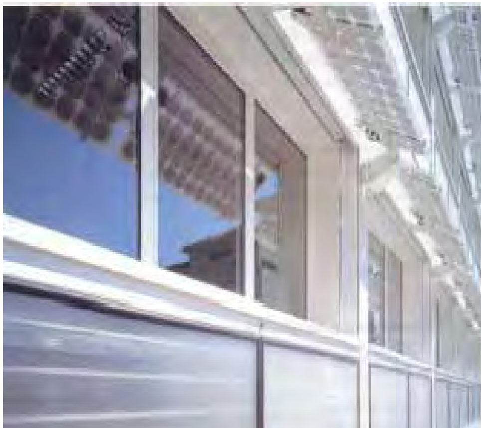
Foto 25. Instalación fotovoltaica en el Edificio "Winterthur" de 48 kWp en Alemania realizado por Conergy.
