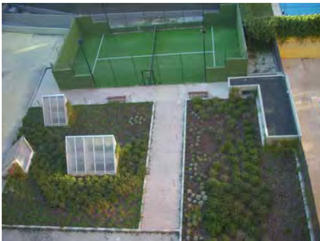
Foto 34. Cubierta ecológica del edificio Trasluz.
