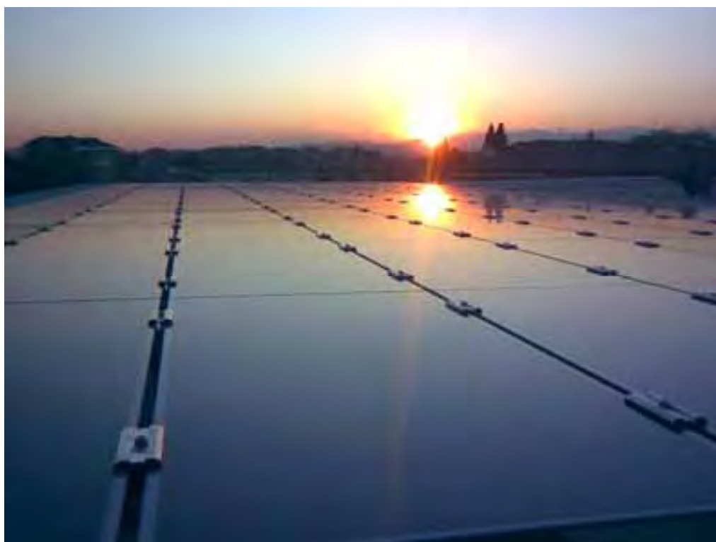
Foto 27. Instalación de capa fina realizada en la Biblioteca Táialà/Fontajau de Girona por el Grupo Conergy.
