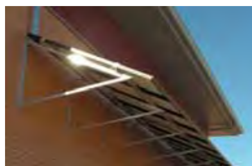
Foto 21. Instalación FV tipo Porche en urbanización MiraMadrid (Madrid) de 2,94 kWp.
