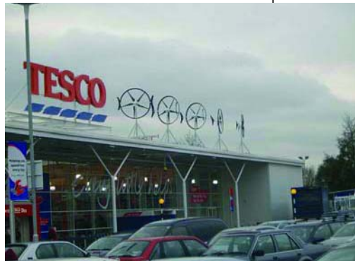
Figura 12. Ejemplo de integración arquitectónica de aerogeneradores.
